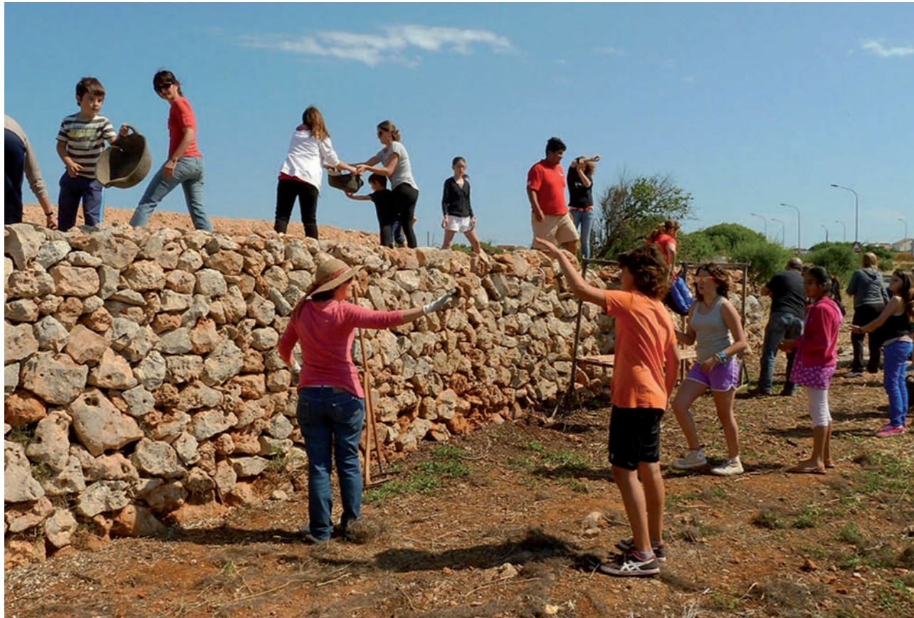
Jóvenes del programa Desafío Menorca ayudaron a completar la recuperación de una de las construcciones ganaderas.
