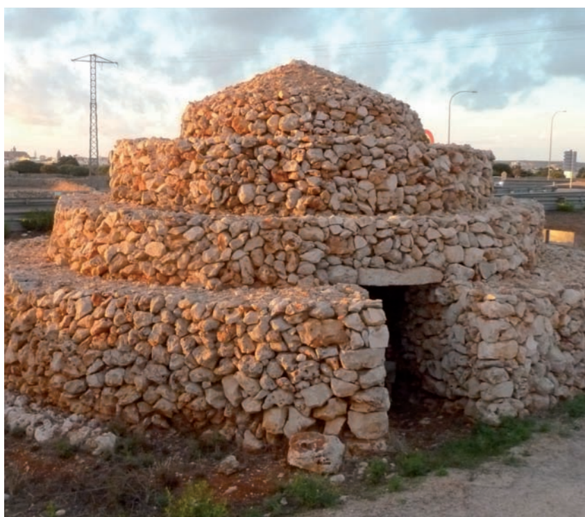
Estado en que se encontraba una de las barracas del proyecto y el resultado final de la intervención.
