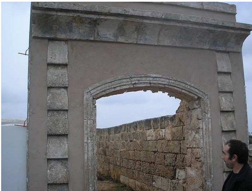
Façana del Cementeri Civil
