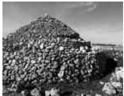
Consolidació del primer anell de la gran barraca de la Ronda Sud.
