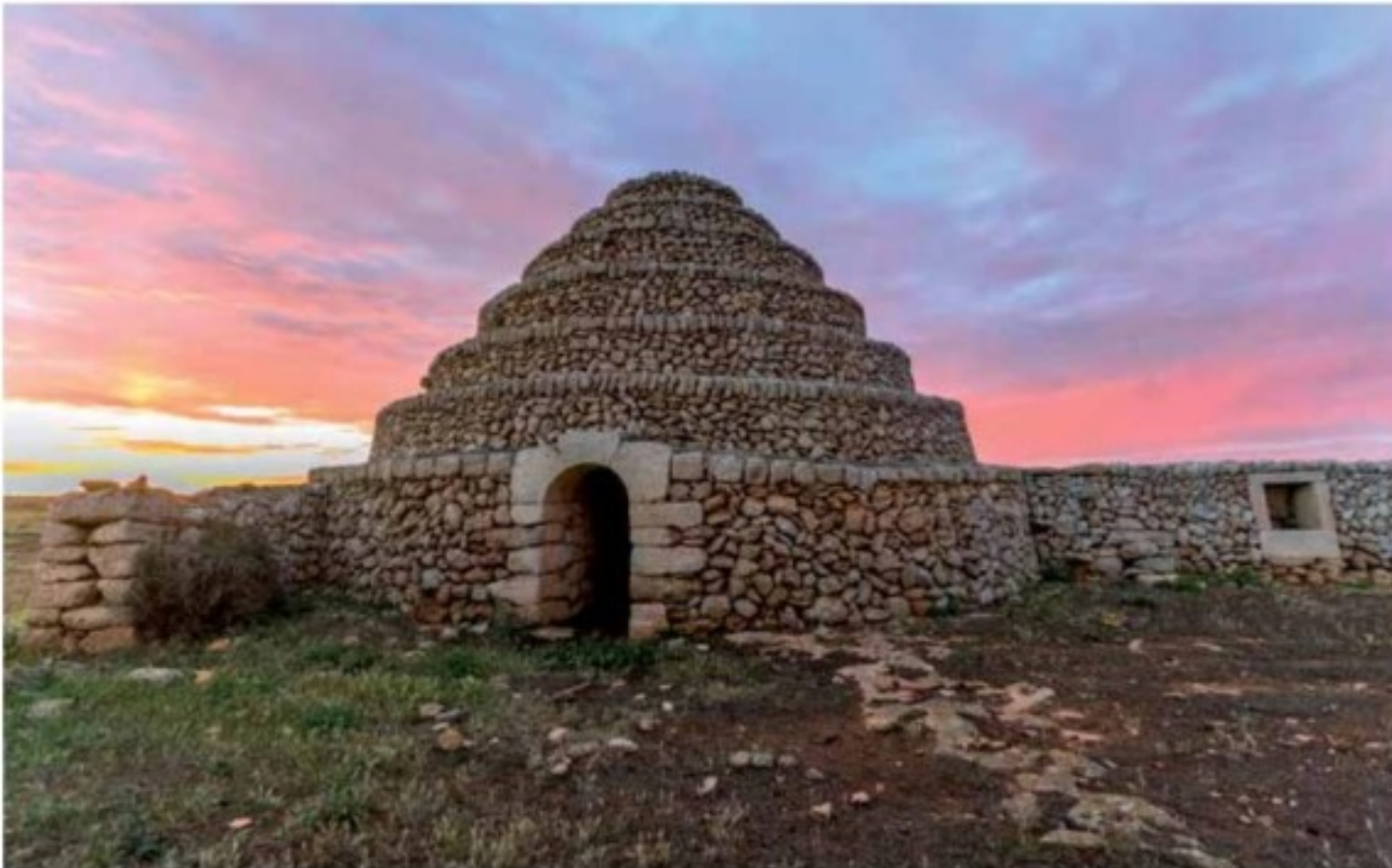
Uno de los mejores ejemplos de "Barraca" en Punta Nati, construida por Bartomeu Castell en 1857. Foto: Sonia Rotger.
