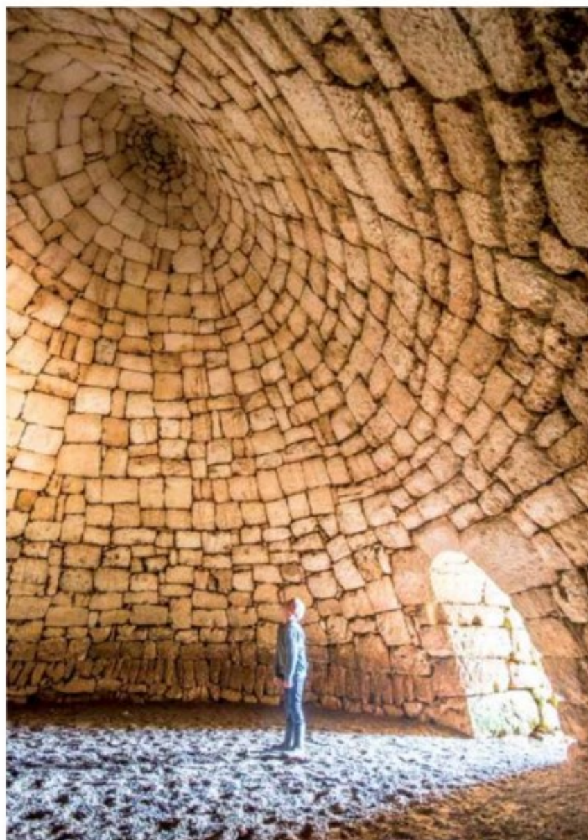
Perspectiva interior de una "Barraca" en Punta Nati. Sorprende la dimensión y perfección constructiva de la piedra en seco. Foto: Sonia Rotger.
